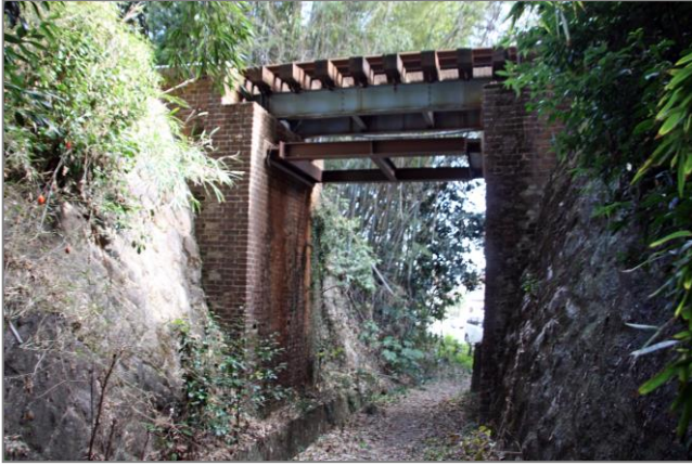
開業(大正9年)当時、建設された「金谷下開渠」場所は上挙母～豊田市間 煉瓦造りの構造物としても貴重なもの。
